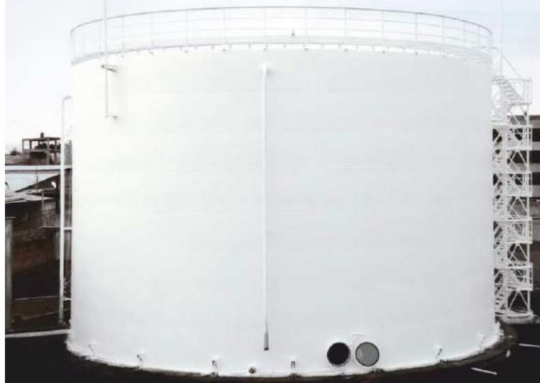
РЕЗЕРВУАР ВЕРТИКАЛЬНЫЙ СТАЛЬНОЙ ОБЪЕМОМ 3 000 КУБ. М
