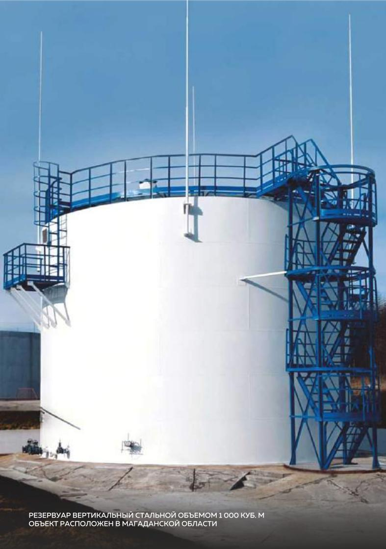
РЕЗЕРВУАР ВЕРТИКАЛЬНЫЙ СТАЛЬНОЙ ОБЪЕМОМ 1 000 КУБ. М
